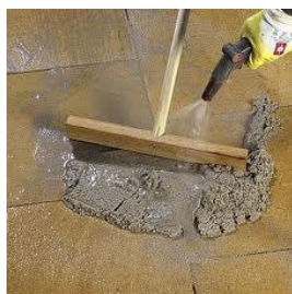
Steg 3. Vattna Granuscan 840 plus och fördela massan med en raka.
