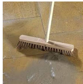
Steg 4. Borsta bort överbliven fogmassa. Om du har släta plattor kan du med fördel använda vatten.
